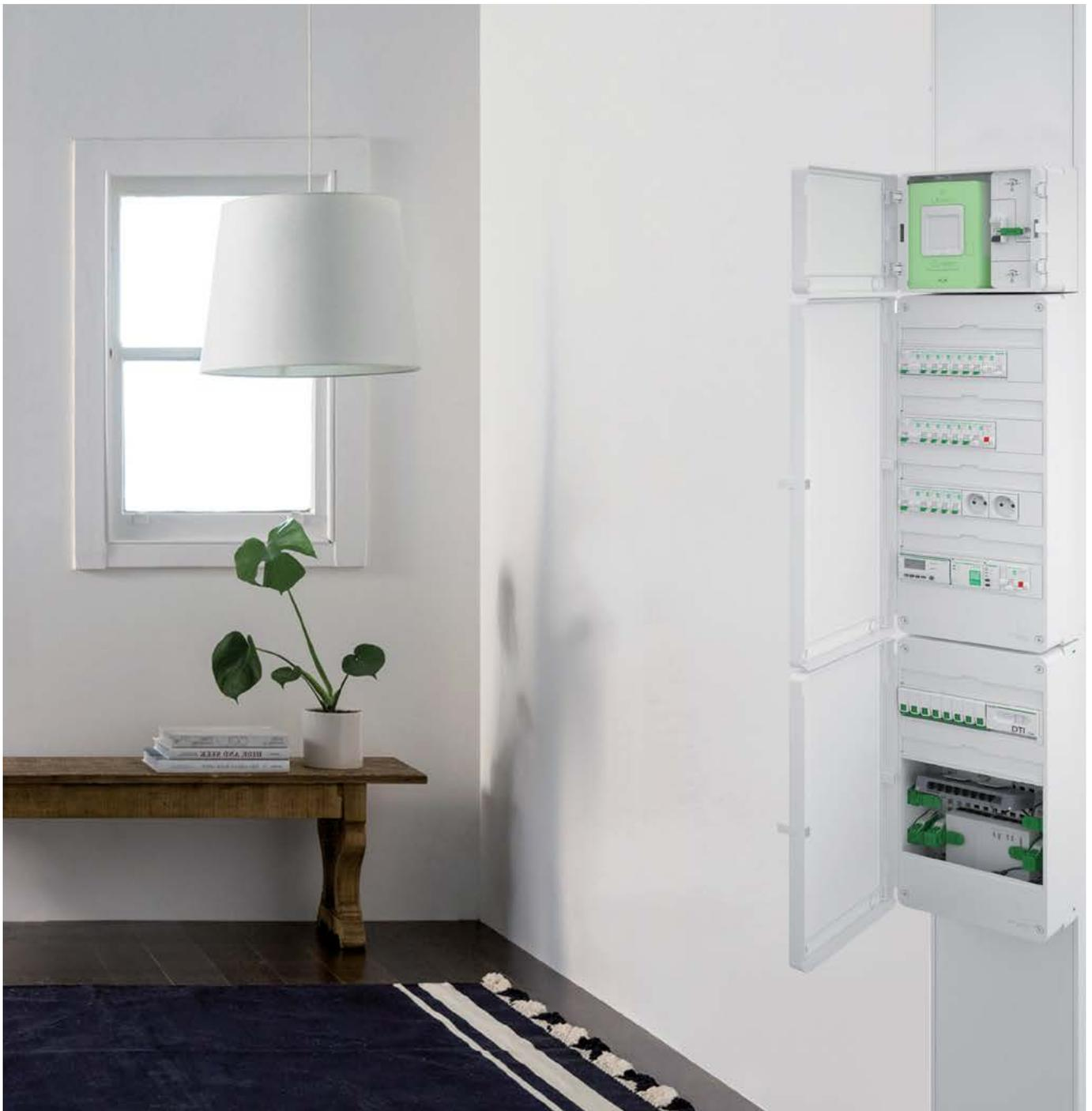
Le tableau électrique connecté Schneider Electric assure la protection des personnes, des biens, l'accès au haut débit pour tout le logement. Il permet aussi à l'occupant de se connecter à distance pour intervenir en cas de défaut ou pour piloter des fonctions comme l'éclairage, le chauffage, le portail, etc.
